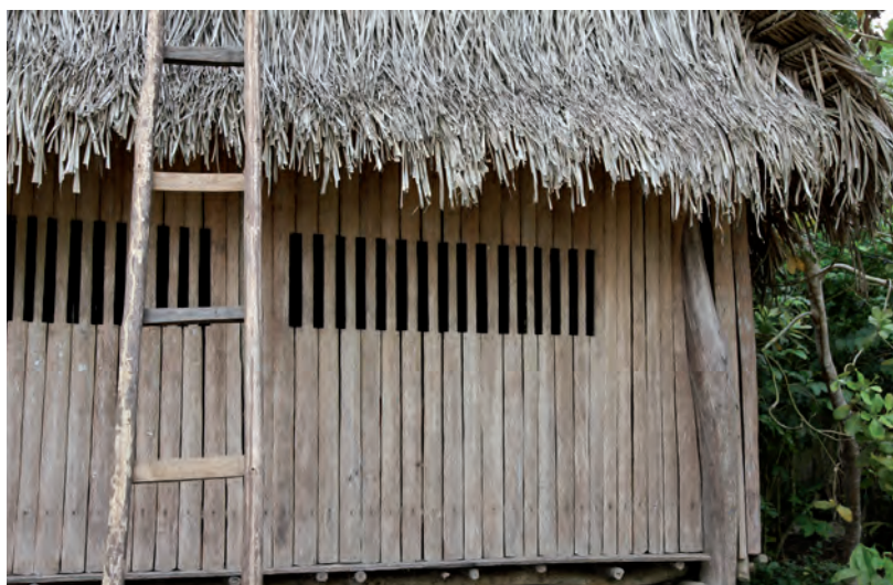
Pared fabricada con las ripas del tronco del Huasaí
