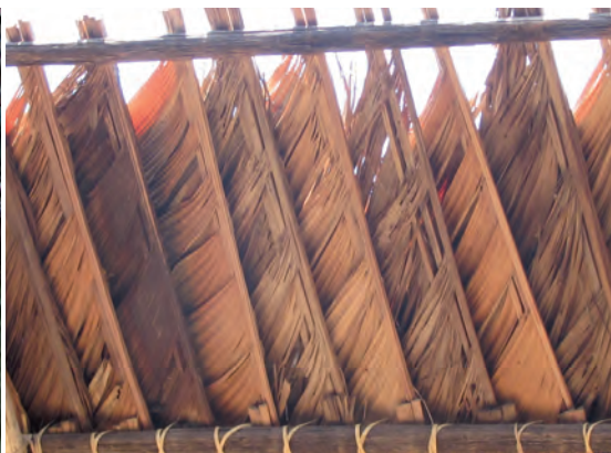
Detalle de techado con hojas de Kampanak
