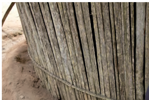
Kinchas construídas con ripas de Shimpi
