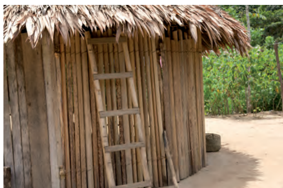
Paredes de casas construídas con el pecíolo de las hojas del Achú
