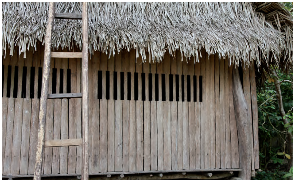
Pared fabricada con las ripas del tronco del Sake
