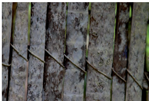
Kinchas construídas con ripas de Shimpi
