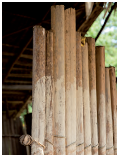
Paredes de casas construídas con el pecíolo de las hojas del Achú
