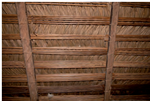
Techos construídos con las hojas y las ripas del tronco del Shimpi
