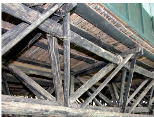
Armazón del techo construido con las ripas fabricadas del tronco
