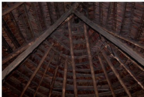
Techos construídos con las hojas y las ripas del tronco del Shimpi
