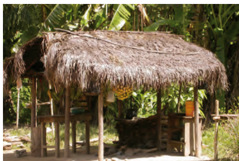
Techo de cocinas de hojas de Motacú dobladas
