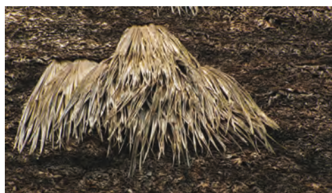
Hojas tapando las goteras del techo
